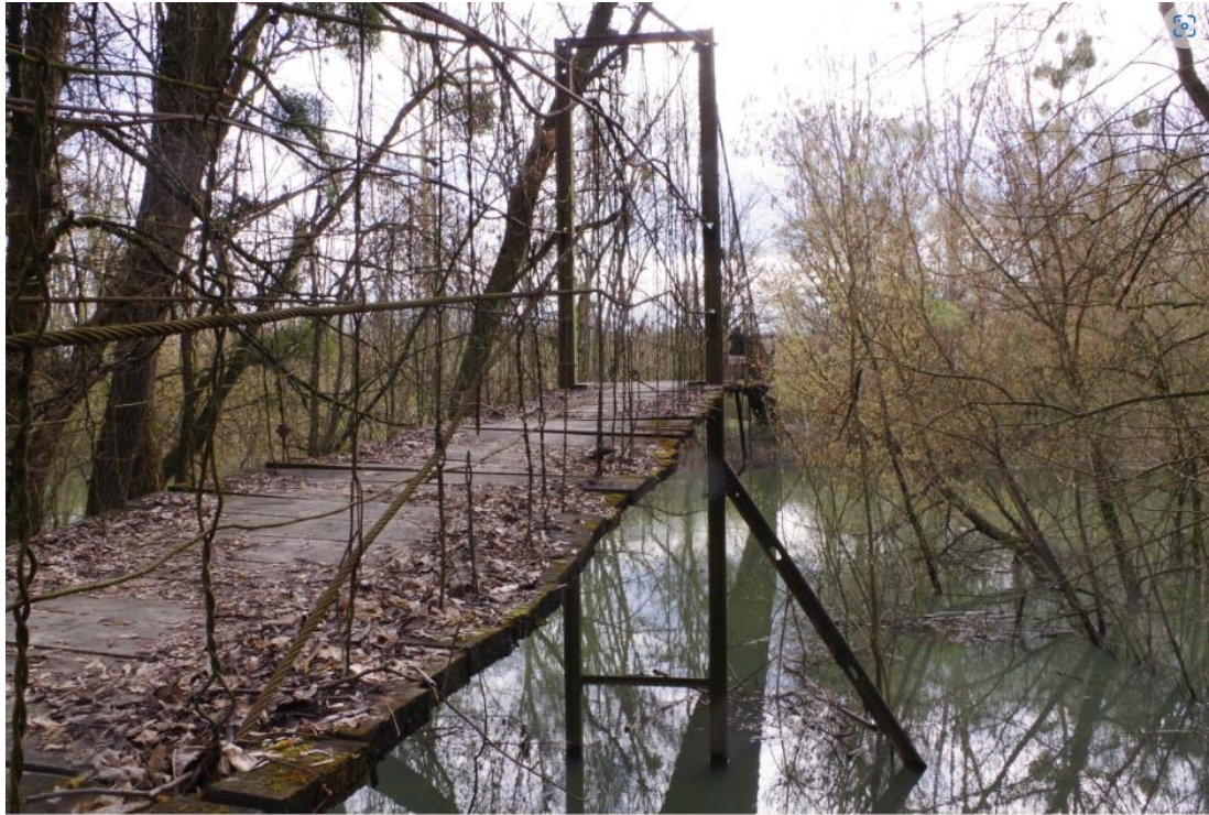
Obr. 2 Existujúca visutá lávka ponad Latoricu
