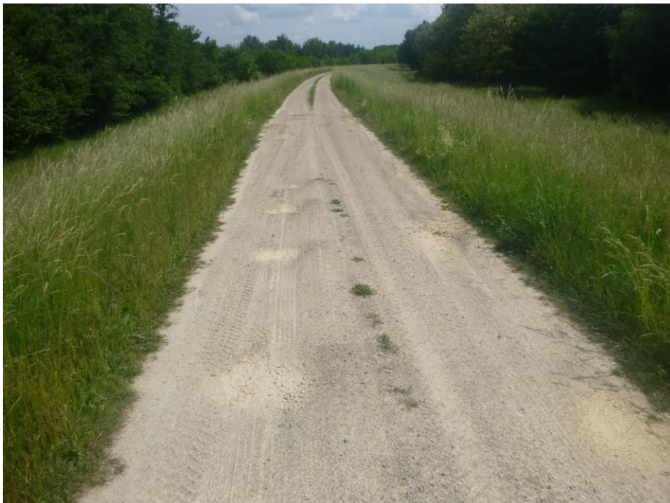
Obr.9 k.ú. Boľany – vedenie cestičky po korune protipovodňovej hrádze rieky Latorica
