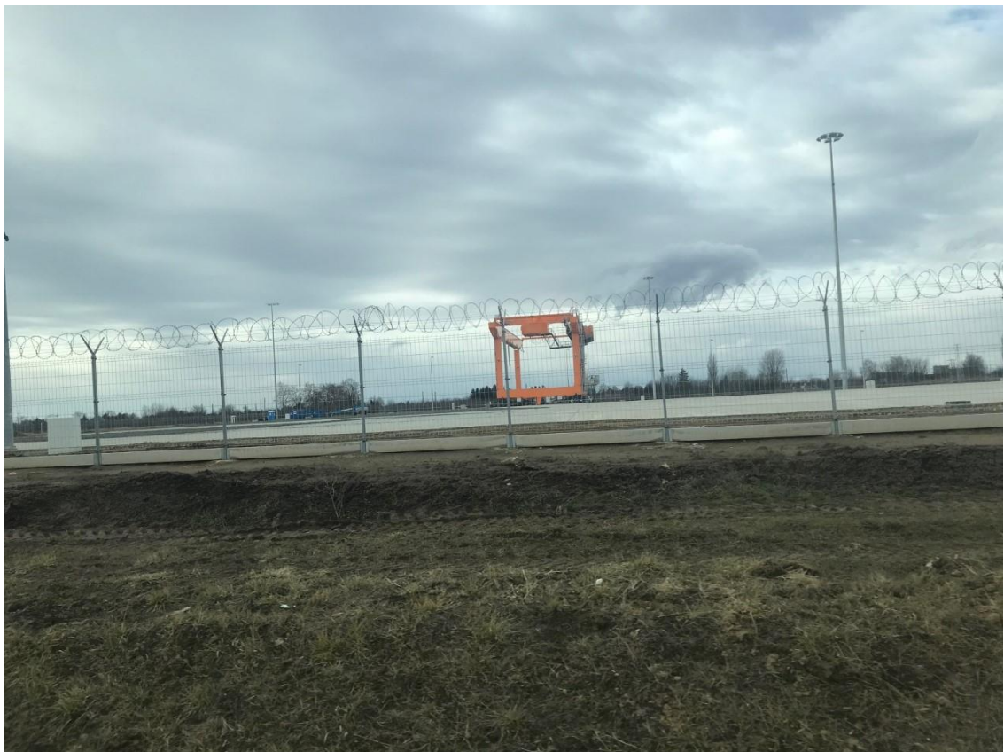
22. ábra: Az East-West Gate terminál építési területe Forrás: saját felvétel
